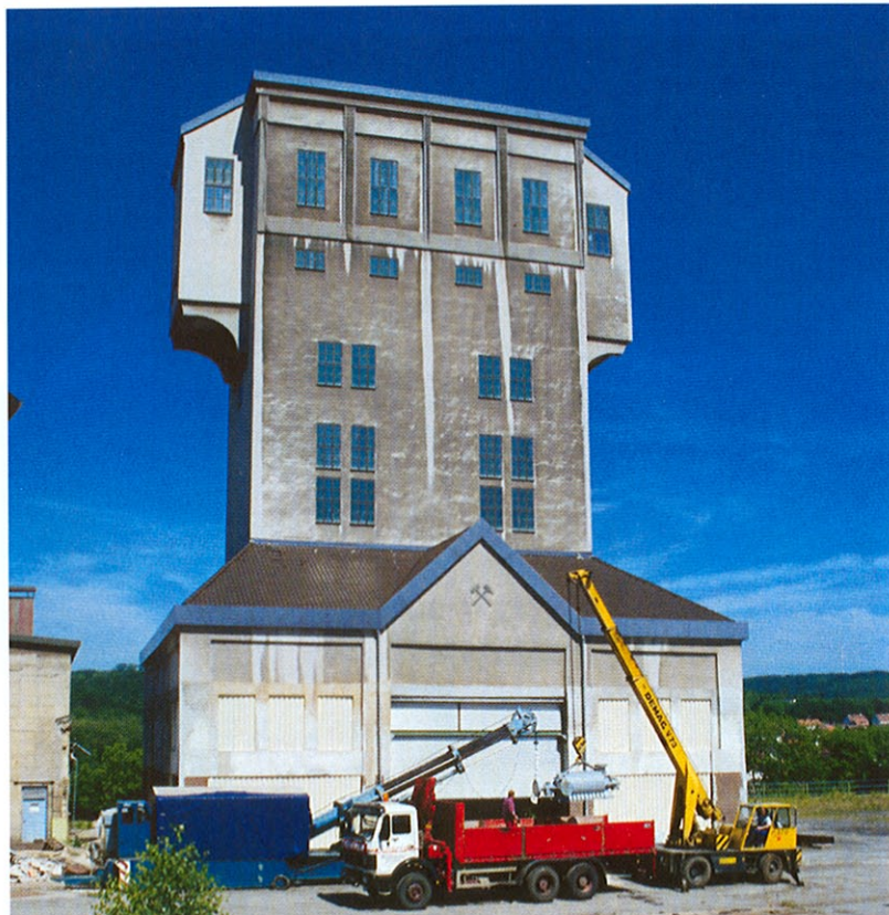
Weithin sichtbar ist die ungewöhnliche Konstruktion des so genannten Hammerkopfförderturmes von Camphausen IV. Fotos: Delf Slotta, DSK-Archiv
