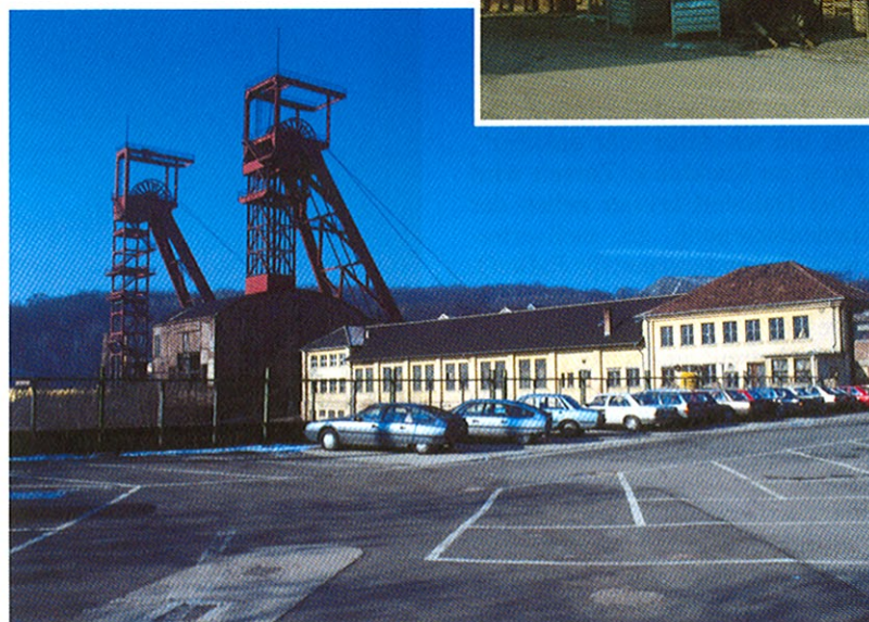
Die rostroten Fördergerüste Jägersfreude III und IV (im Hintergrund, von links): Die beiden Wahrzeichen des Ortes wurden 1988 abgebrochen.
