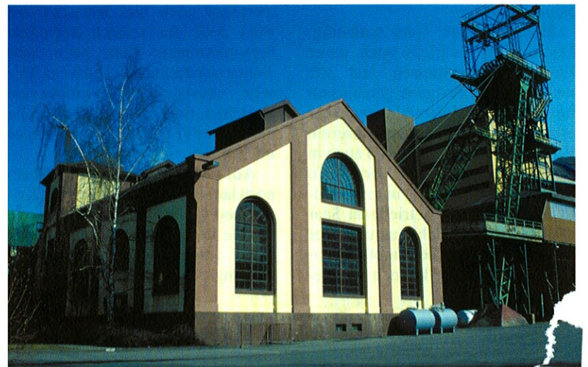
Die Ensdorfer Grubenanlage Duhamel, links das eingeschossige Fördermaschinenhaus, daneben das 35 Meter hohe Stahlfachwerk-Fördergerüst.
