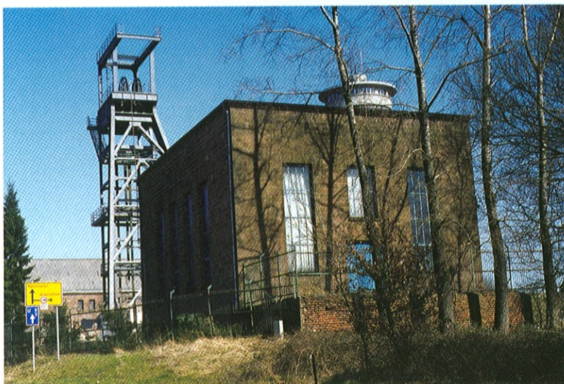
Eine Einheit: Fördermaschinenhaus und Fördergerüst am Schacht Holz.
