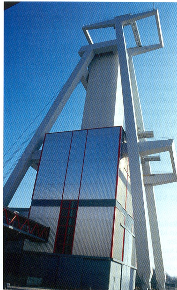
Avantgardistische Architektur an der 90 Meter hohen Gesamtkonstruktion. Fotos: Delf Slotta
