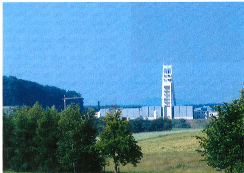
Keine aktive Schachtanlage an der Saar liegt so malerisch im Grünen wie der Nordschacht des Bergwerks Ensdorf auf dem Hoxberg. Fotos: Delf Slotta
