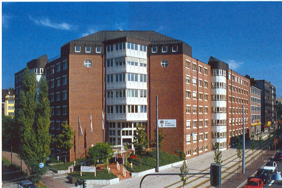
Harmonisch passt sich der moderne, verklinkerte siebenstöckige Verwaltungsbau der Knappschaft von 1992 an der Westspange Saarbrücken dem städtebaulichen Umfeld an.
