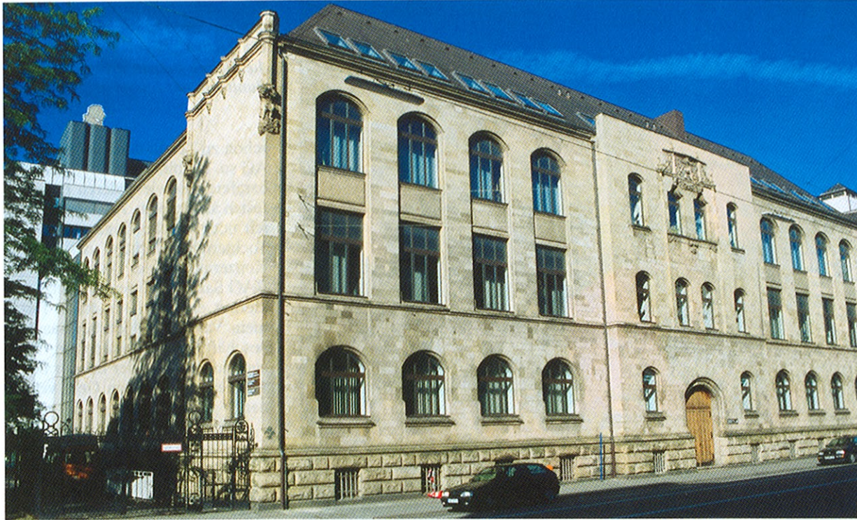
Vor fast 100 Jahren wurde mit den Bauarbeiten für die Königliche Bergschule in Saarbrücken begonnen.
