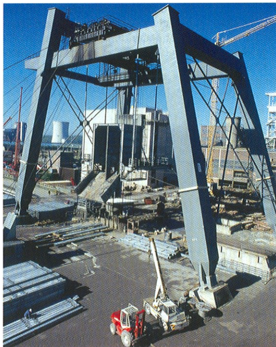
Fördergerüst Göttelborn im Aufbau.
