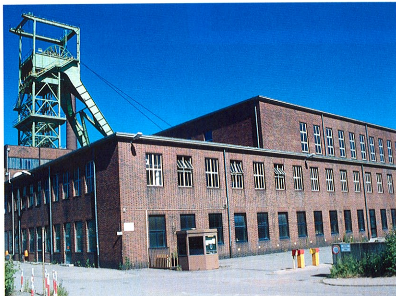
Symmetrien und rechte Winkel bestimmen die strenge Architektur des Zechenhauses. Auf Reden wurden Ende 1995 die letzten Kohlen gehoben.
