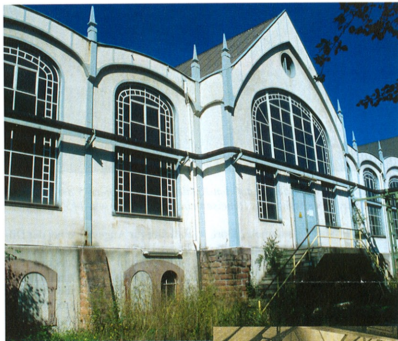
Renovierte Schauffassade der Maschinenhalle Heinitz 2000.
