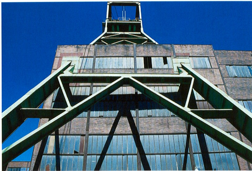
Eine Landmarke: das Vollwandfördererüst Reden V. Fotos: Delf Slotta
