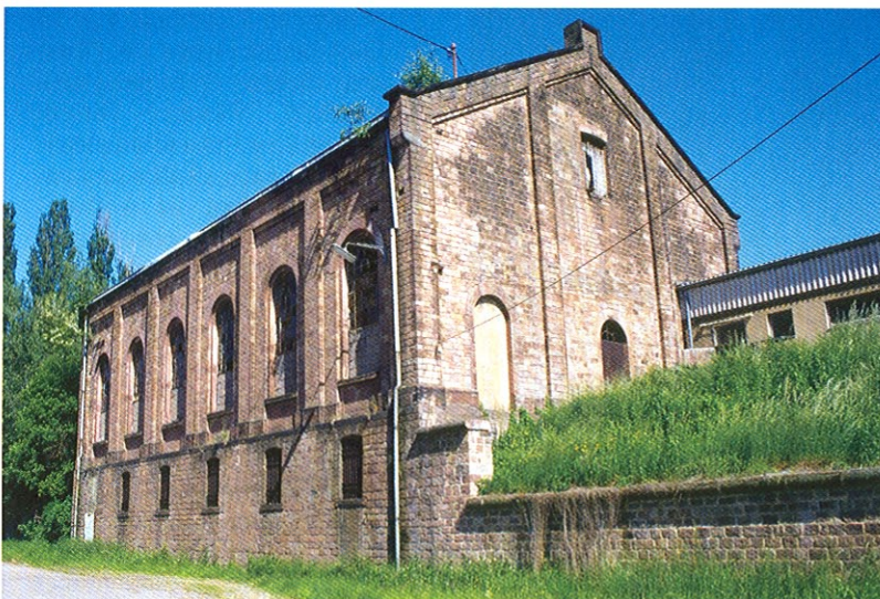
Giebel und Längsseite des Fördermaschinenhauses Schacht III.
