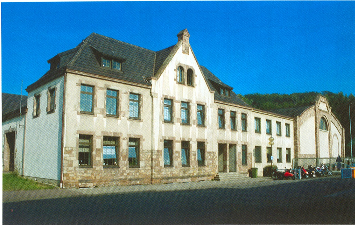
Das Zechenhaus (links) und die Waschkaue bilden auf Jägersfreude funktionell und optisch eine Einheit.
