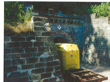
Rischbach-Stollen (St. Ingbert)
