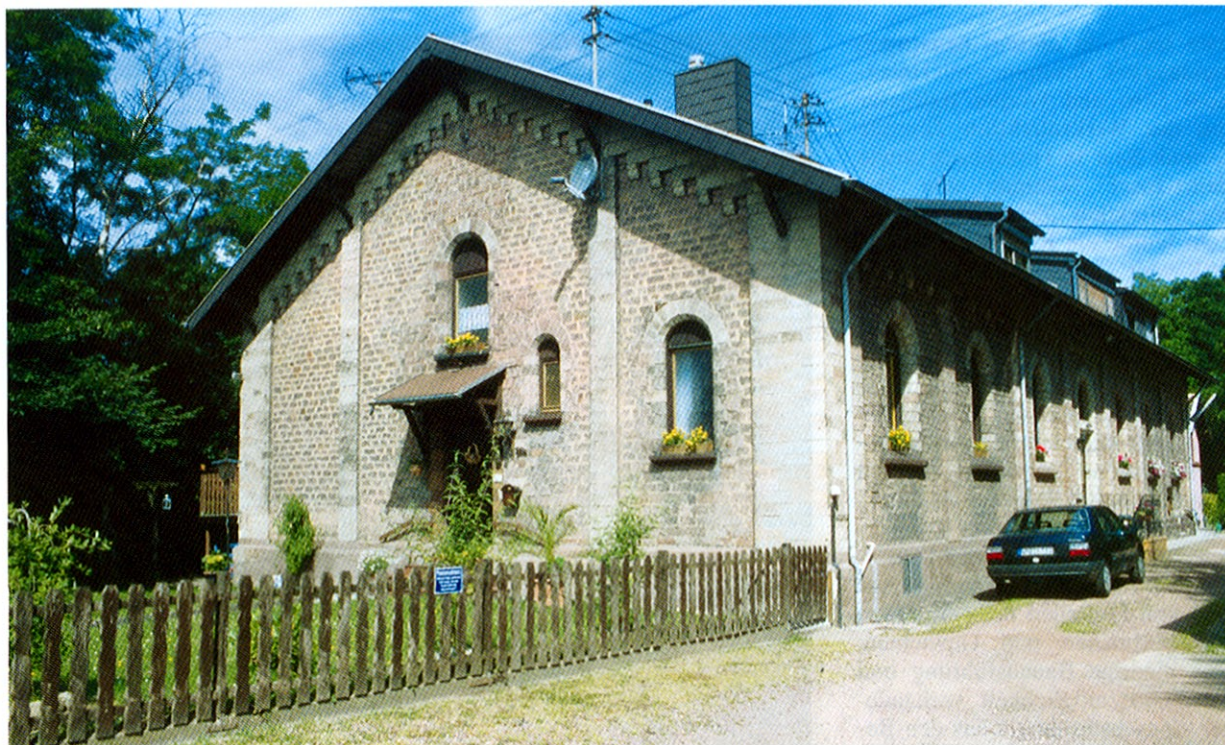
Fast noch im ursprünglichen Zustand: der Betsaal in der Altenkesseler Gerhardstraße, den 1870 noch ein Glockenturm mit Kreuz auf der „Kirchturmspitze“ als Gotteshaus kenntlich machte. Heute ist das Wohnhaus in Privatbesitz. Foto: Delf Slotta
