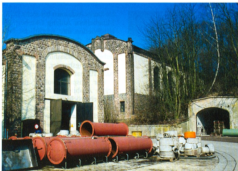
Fördermaschinenhaus und Schachthalle der Grubenanlage.
