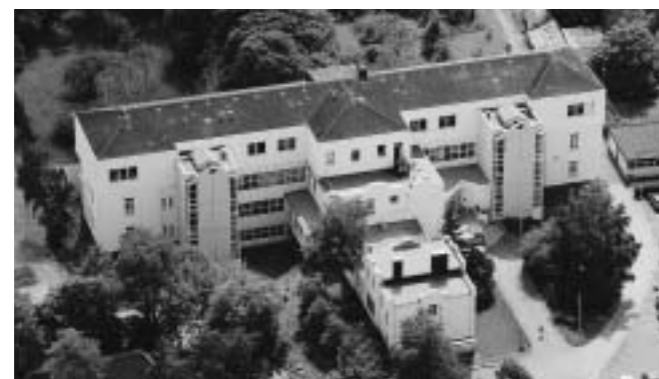
SHG-Klinik Halberg heute: Gesamtkomplex im Luftbild (2001)
