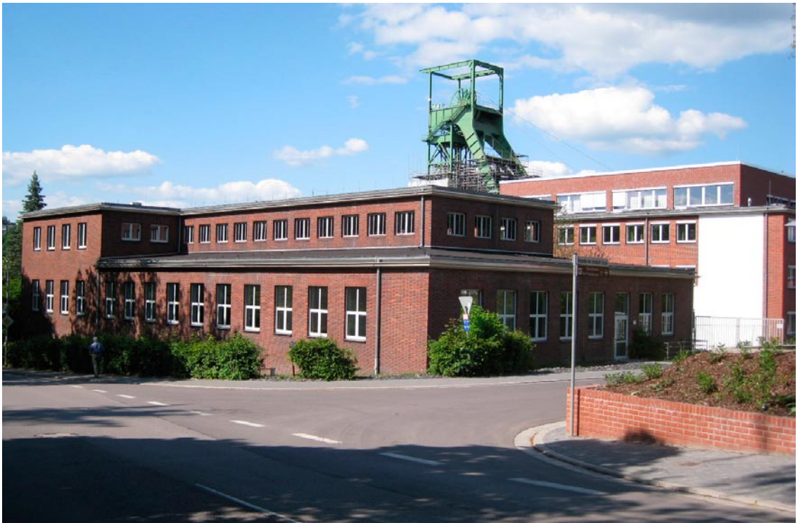
Zechenhaus Reden heute in der Rückansicht mit dem Fördergerüst Schacht Reden V (Aufnahme: 2009).
