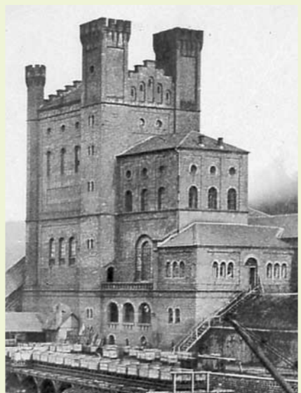
Malakoffturm auf Grube Heinitz, 1866.
