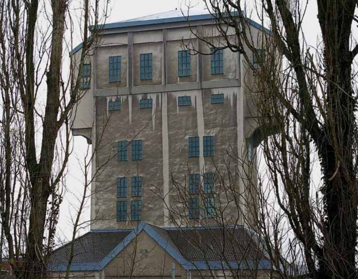
Quierschied-Fischbach/Camphausen: Förderturm Schacht IV – Seitenansicht des Hammerkopfturms (1908/11).
