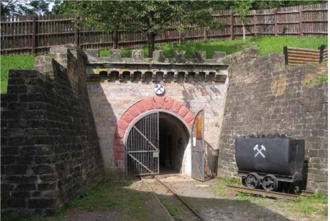
St. Ingbert: Mundloch des A-Stollens auf der Rischbachanlage, heute Besucherbergwerk (1840/45).
