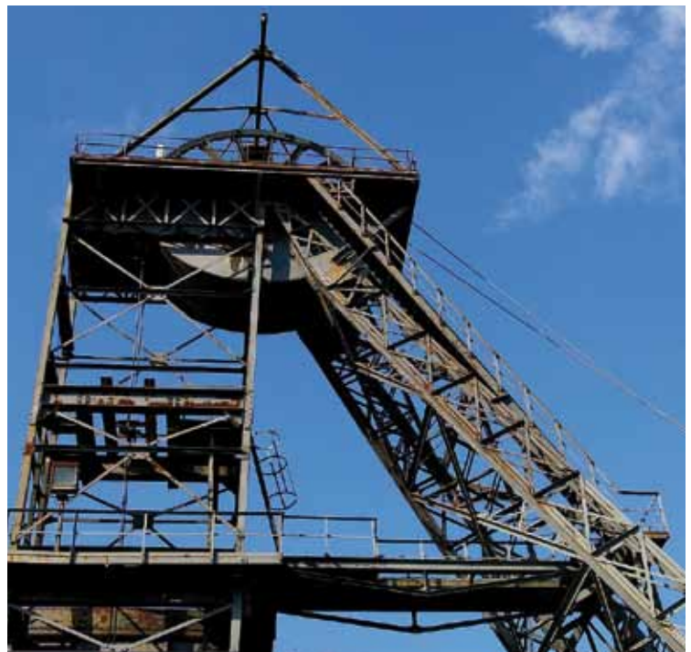
Neunkirchen-Bauershaus: Fördergerüst an der Gegenortschachtenanlage (1900).
