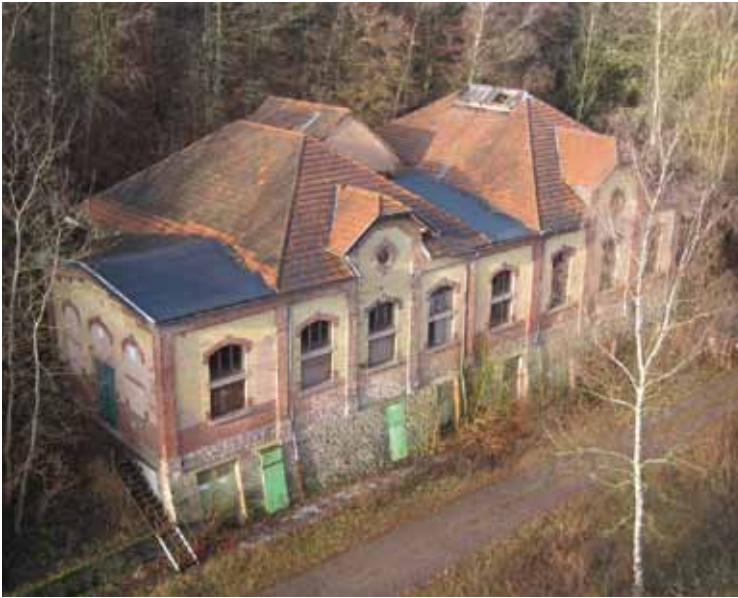
Schiffweiler-Heiligenwald: Elektrische Zentrale (Schalthaus) der Grube Itzenplitz (1907/15).
