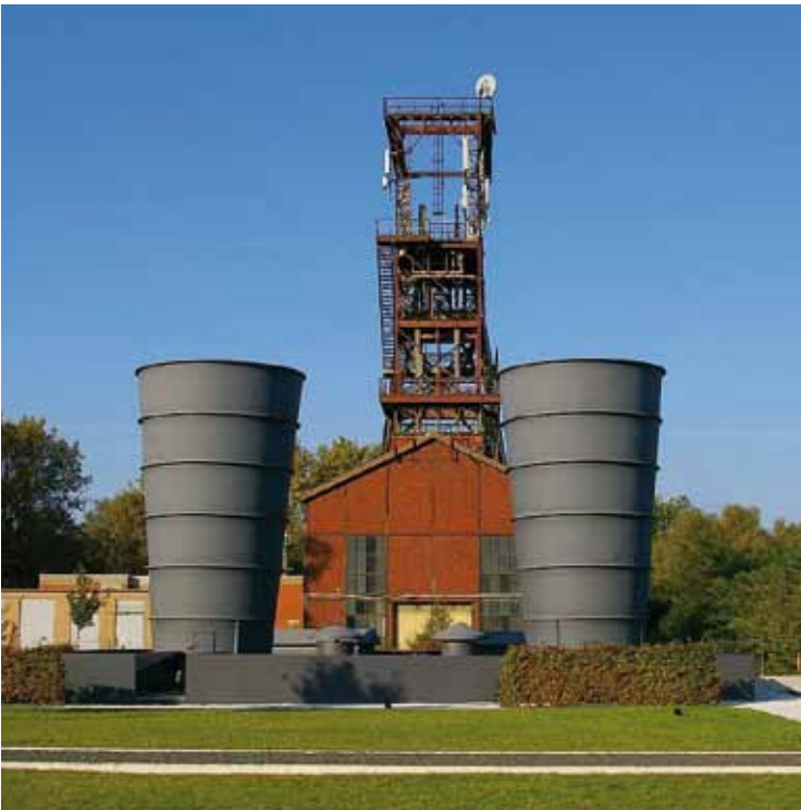
Saarbrücken-Burbach: Fördergerüst am Alsbach-Schacht der Grube Luisenthal (1916).
