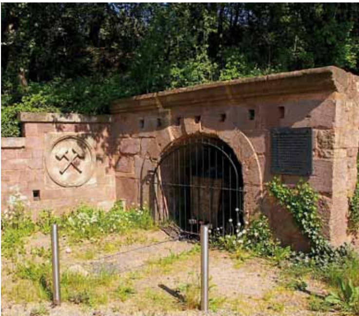
Heusweiler-Dilsburg: Mundloch des Dilsburg-Stollens (1844/45).
