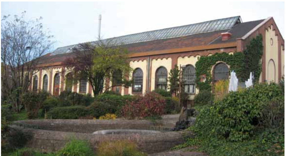
Ensdorf: Kompressorenhalle auf der Anlage Duhamel des Bergwerks Saar (1917/18).
