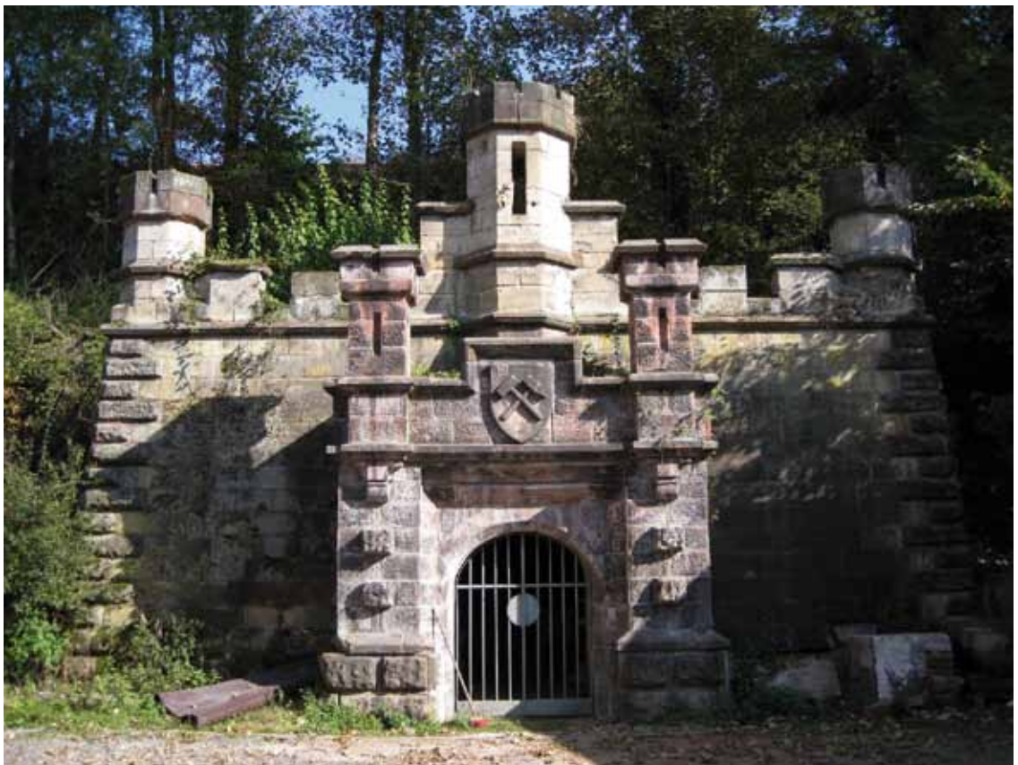
Saarbrücken-Von der Heydt: Mundloch-Eingangsarchitektur zum „Bierkeller“ (1875).
