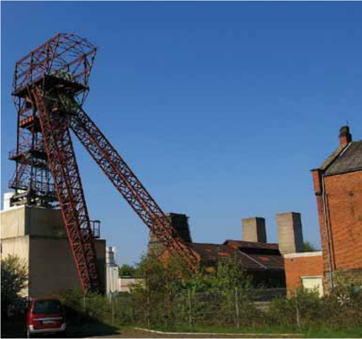
Saarbrücken-Klarenthal: Fördergerüst II (1908), Fördermaschinenhaus und Kompressorenhaus am Delbrück-Schacht II.
