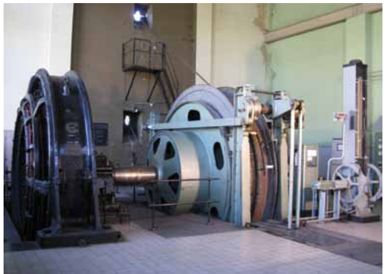
Schwalbach: Fördermaschine am Ney-Schacht des Bergwerks Saar (1927/58).
