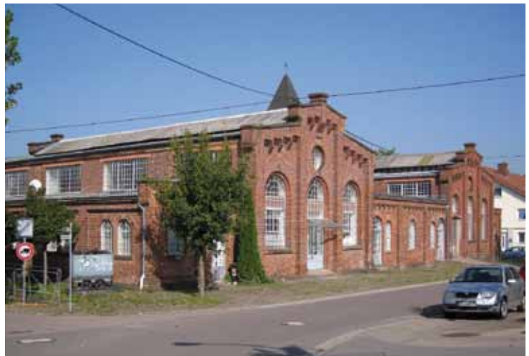
Püttlingen-Köllerbach/Engelfangen: Zechenhaus der Schachanlage Viktoria III (1910).
