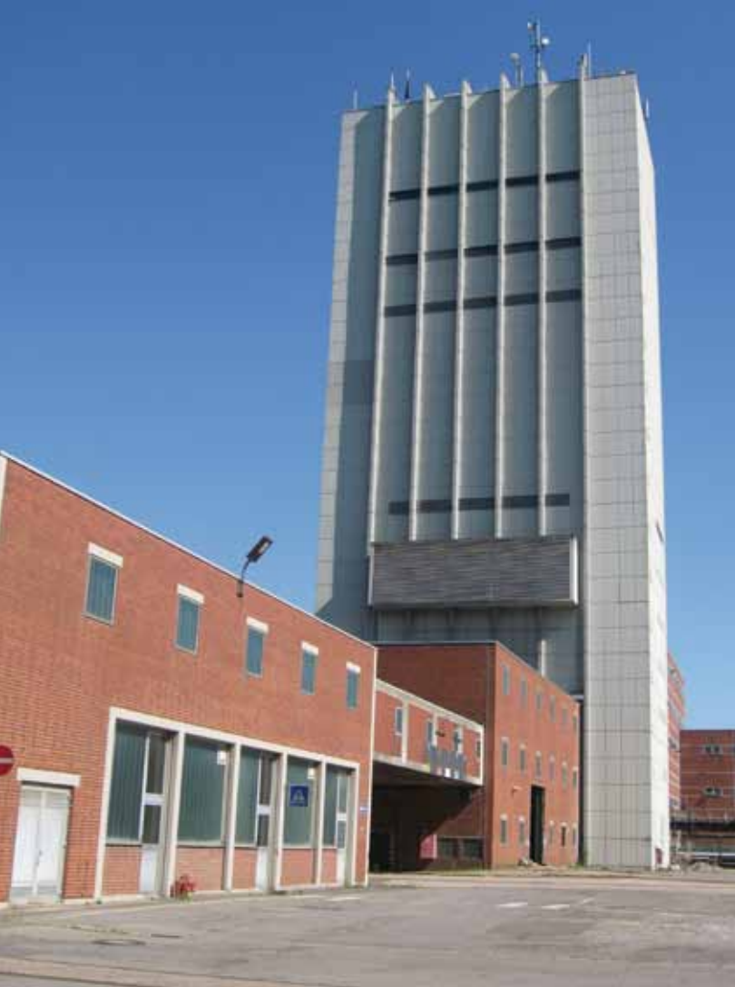
Großrosseln-Karlsbrunn: Förderturm der Schachtanlage Warndt (1960/61).
