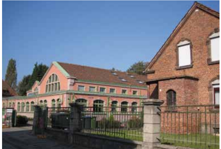
Saarbrücken-Dudweiler: Kaffeeküche (rechts) und Zechenhaus auf der Schachanlage Pascal (1926).
