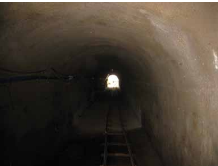
St. Ingbert: Im Inneren des A-Stollens der Grube St. Ingbert.
