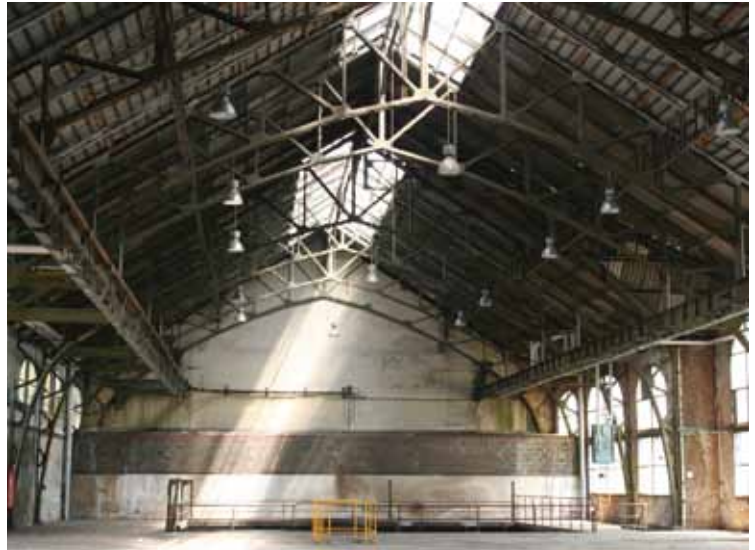
Neunkirchen-Heinitz: Kokereigasmaschinenzentrale Heinitz mit offener Stahlfachwerk-Trägerkonstruktion (1904).
