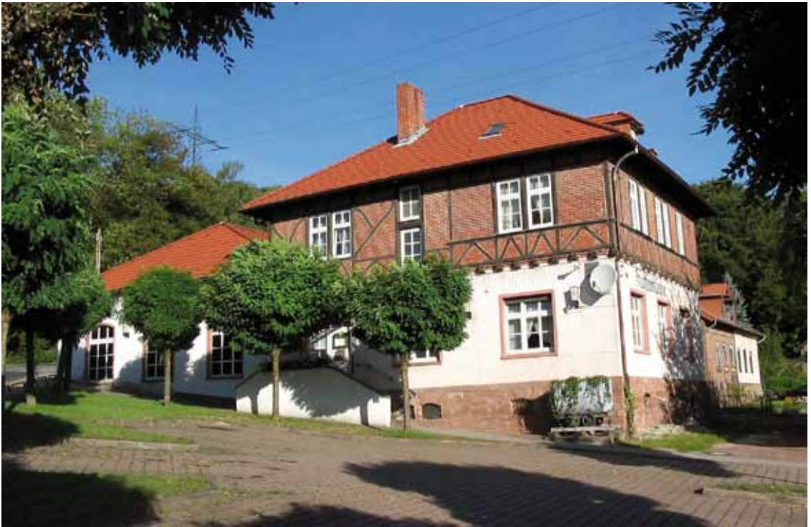
Friedrichsthal-Maybach: Kaffeeküche der Grube Maybach (1897/1936).
