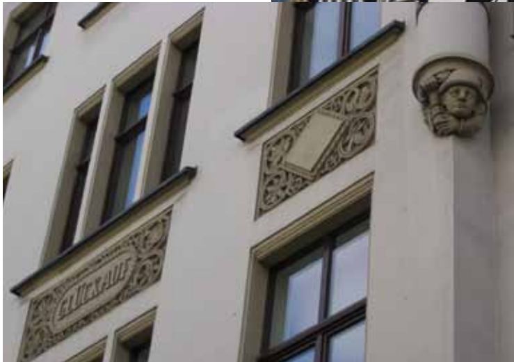
Saarbrücken: Alte Saarbrücker Knappschaft – Detail von der Schaufassade (1901/02).
