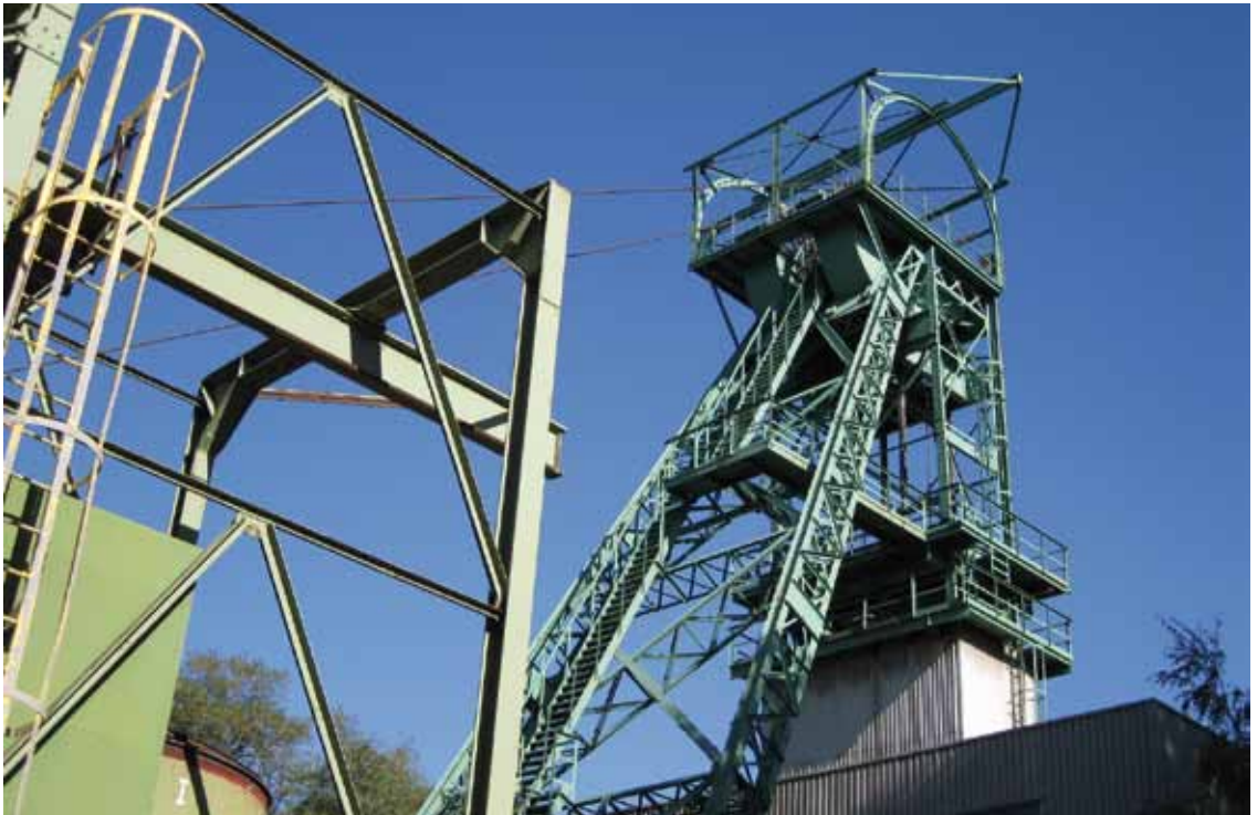
Schwalbach: Fördergerüst am Ney-Schacht des Bergwerks Saar (1899).
