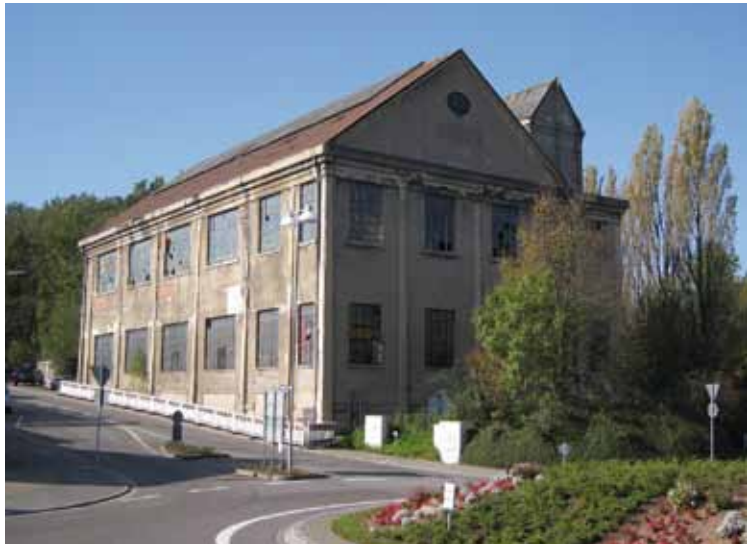
Sulzbach-Hühnerfeld: Umspannwerk (um 1925).
