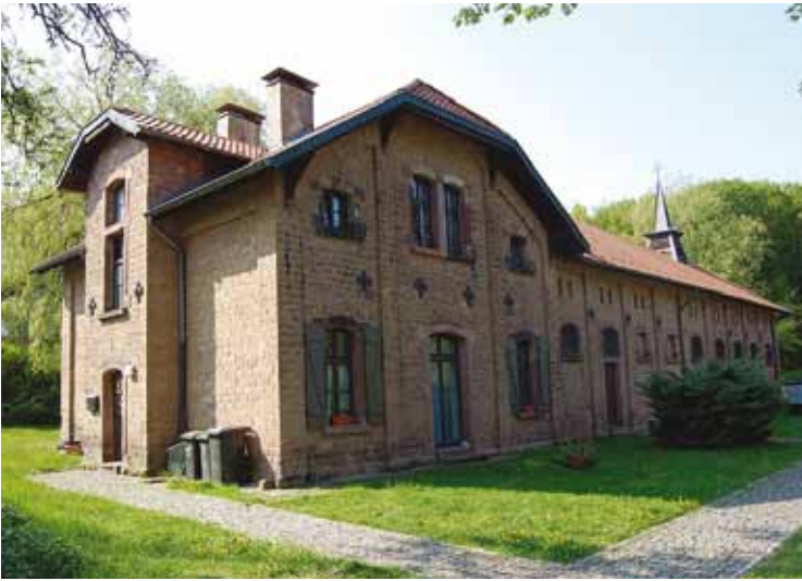
Sulzbach-Brefeld: Pferdestall der Grube Brefeld (1898/99).
