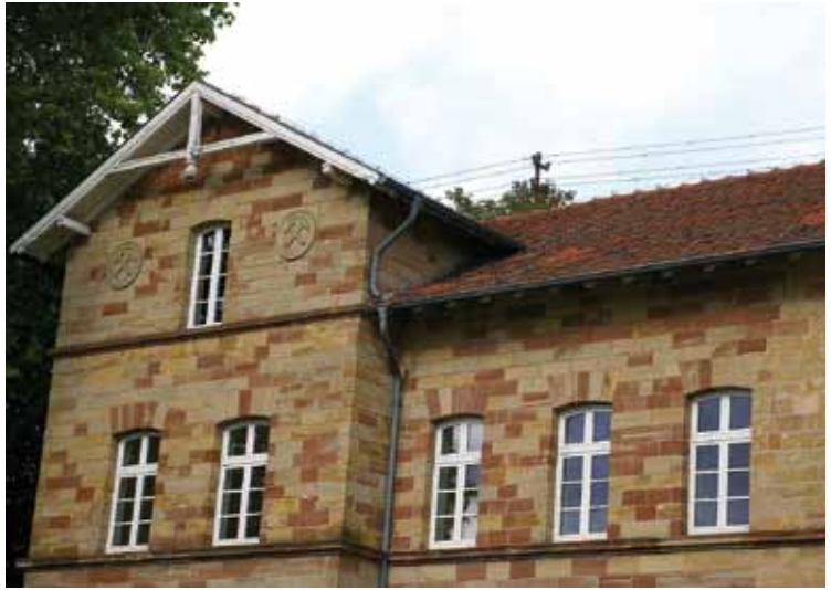
Ens Dorf: Hauptgebäude der Berginspektion in Ens Dorf (1889/90).
