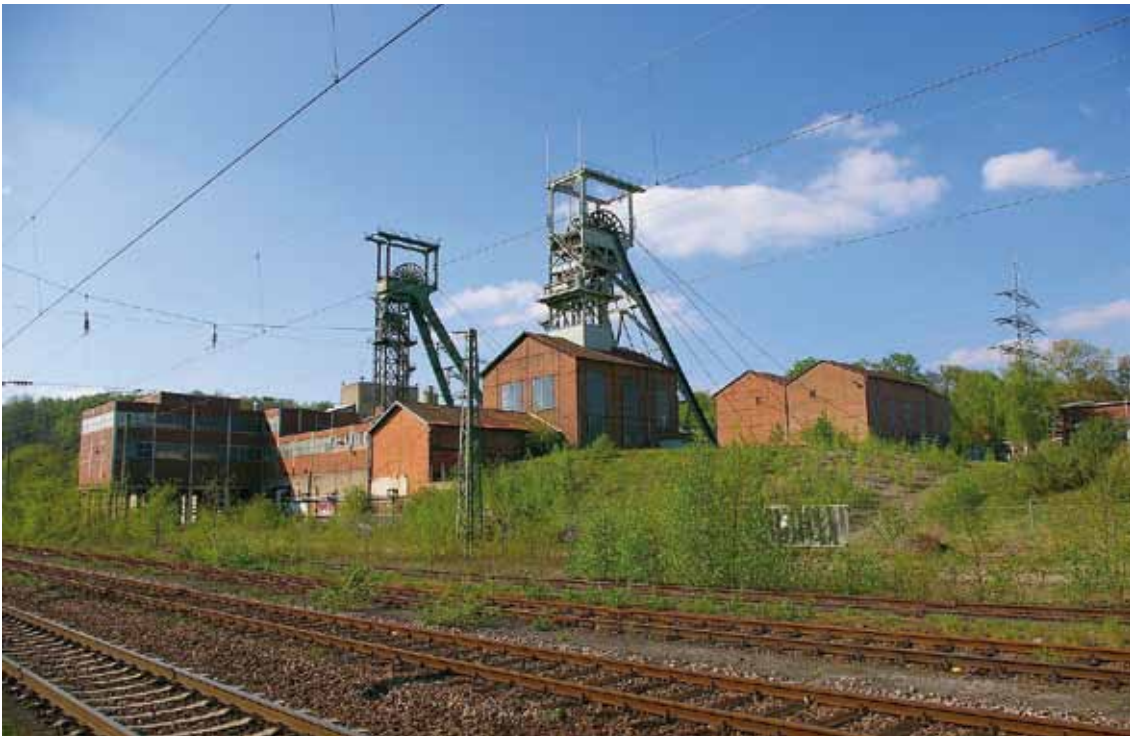
Völklingen-Luisenthal: Fördergerüste Richard I (1962, links) und Richard II (1952) der Grube Luisenthal.
