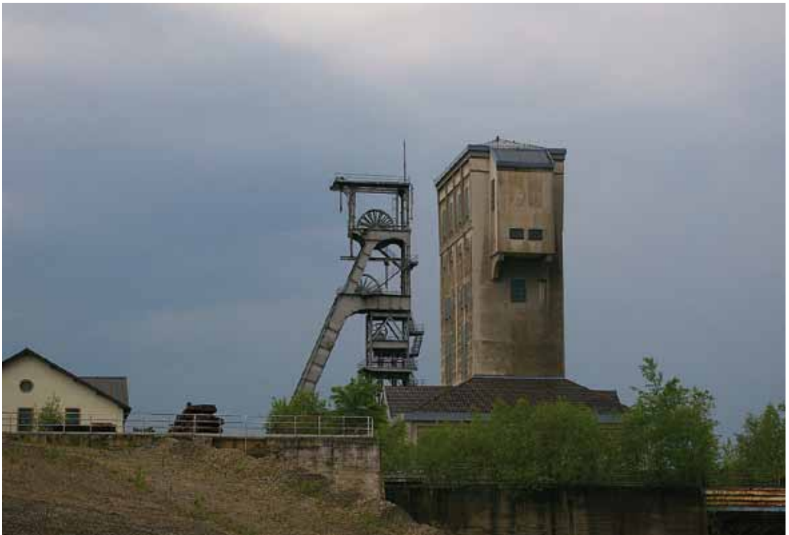
Quierschied-Fischbach/Camphausen: Förderturm Schacht IV (1908/11) und Fördergerüst Schacht II (1962) der Grube Camphausen.
