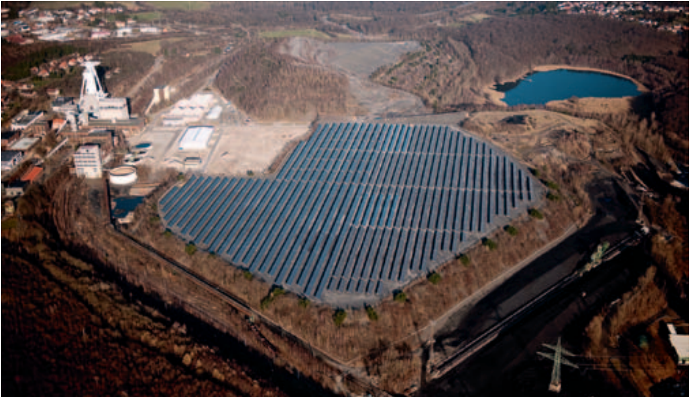
Blick aus der Luft auf den Standort Göttelborn mit seinem modernen (nie genutzten) Förderturm und dem neuen Photovoltaik-Feld | Foto: D'Angiolillo
