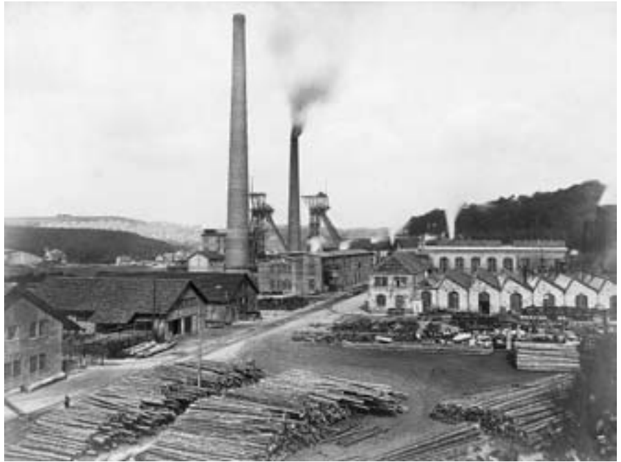
Warndtgrube Velsen mit den Gustavschächten, Holzplatz und Zechenhaus | Foto: RAG
