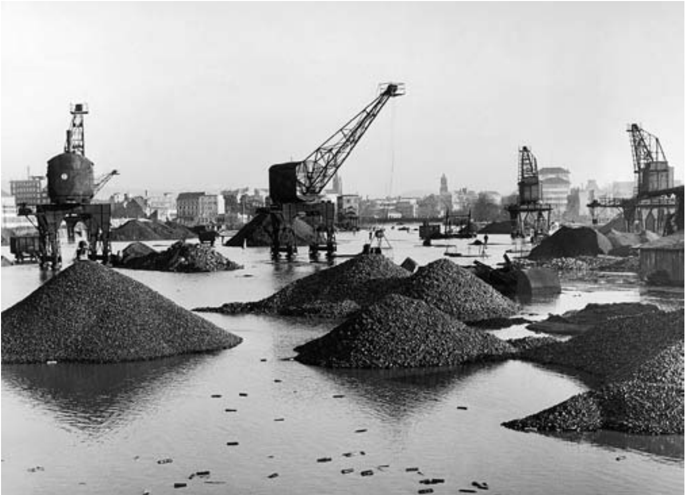
Die Saarbrücker Hafensinsel beim Saarhochwasser 1970 | Foto: RAG
