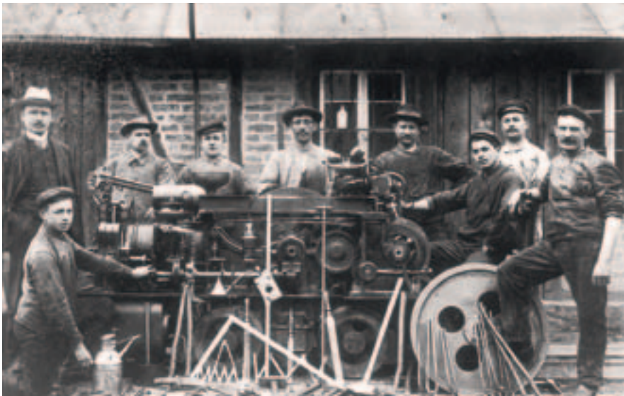
Bergleute der Grube Itzenplitz in Heiligenwald bei Reparaturarbeiten an einer Grubenlock um 1913 | Foto: RAG
