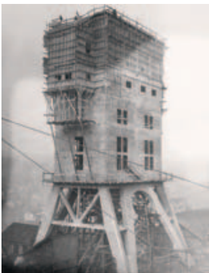
Camphausen IV – der weltweit erste Förderer in Stahlbetonweise, während des Baus 1911 | Foto: RAG
