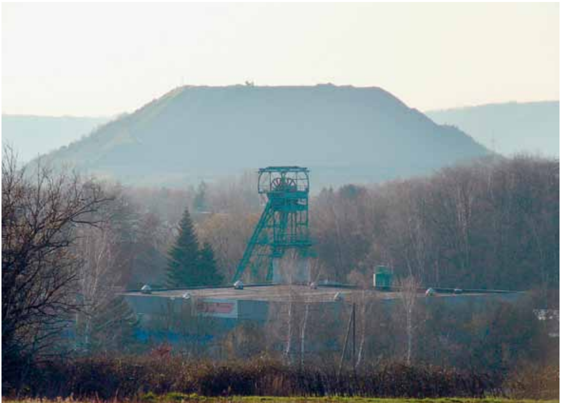
Schwalbach: Betriebsgebäude des Ney-Schachts und Haupthalde des Bergwerks Saar am Standort Ens-dorf-Duhamel (2009).
