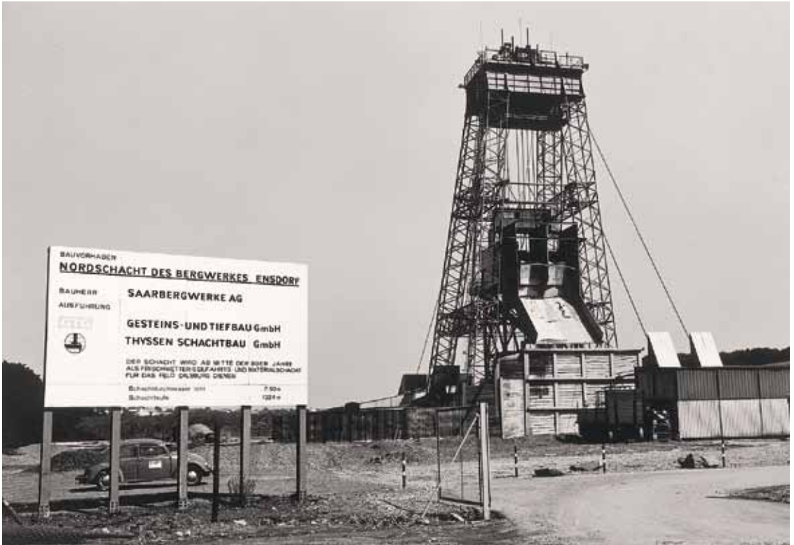
Lebach-Falscheid: Teufgerüst des neuen Nordschachts des Bergwerkes Ens Dorf (1982).
