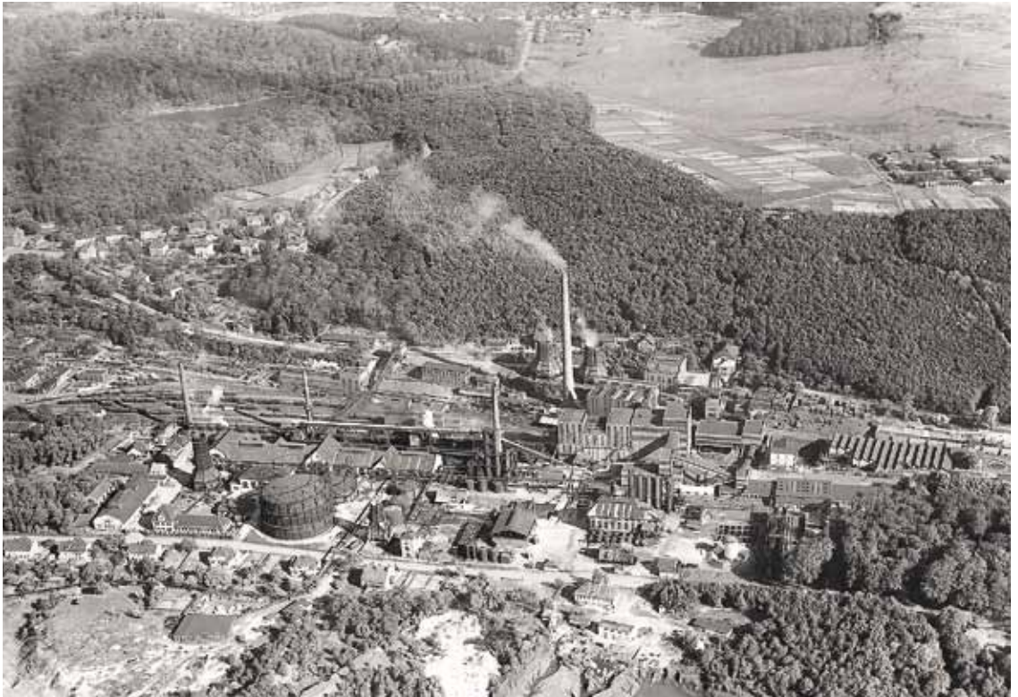
Neunkirchen-Heinitz: Tagesanlagen der Grube und Kokerei Heinitz im Holzauerthal (1960).
