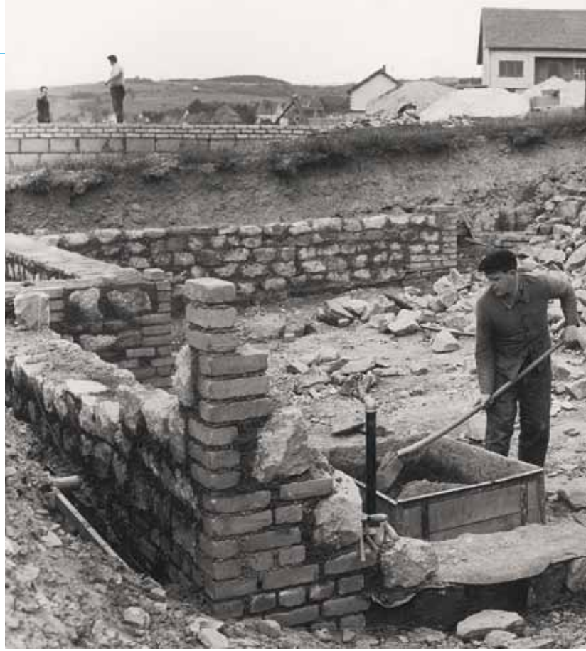
Der Bergmann als Bauherr und Baumeister: Bergmann der Grube Jägersfreude auf der Baustelle (1962).
