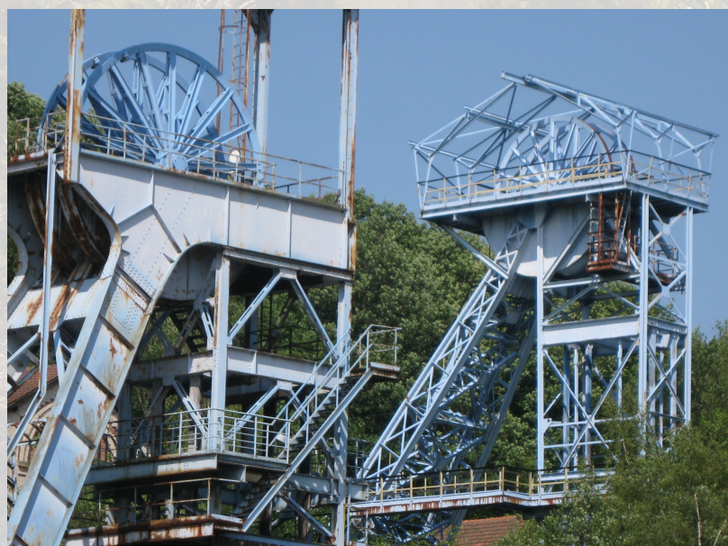
Das charakteristische Fördergerüst III der Grube Itzenplitz von 1886 (rechts) gilt als ältestes noch bestehendes Beispiel von Eisenschwerkstrukturen jener Zeit.
